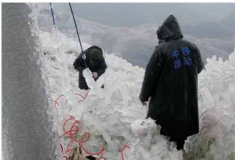
在廣西，搶修受冰災影響的通信線路
