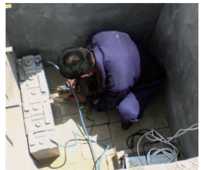
在甘肅，通過地坑式蓄電池安裝技術節能降耗
