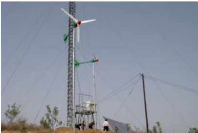
在陝西，建設風光互補型供電系統
