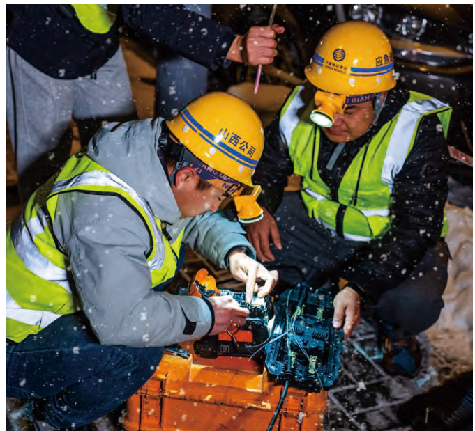
中國移動在山西太原杏花嶺區風雪天的光纜故障搶修現場
