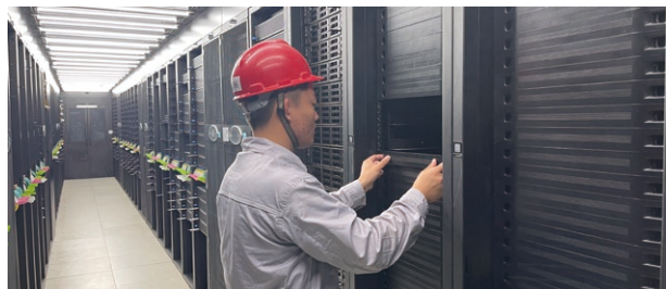
◎ 補齊盲板避免冷量損失
