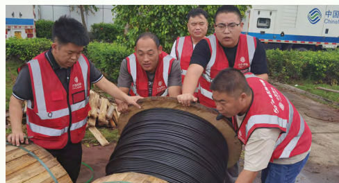
维护员进行光缆抢修
