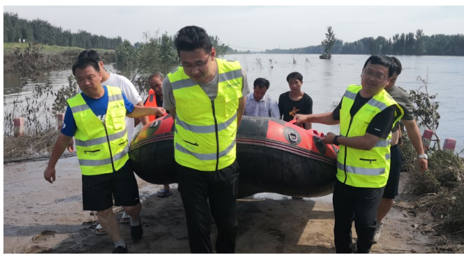
河北保定北拒马河跨河布缆通信抢修
