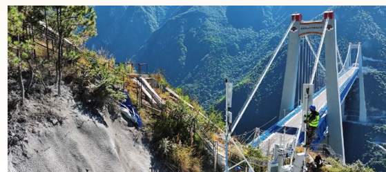
虎跳峡金沙江铁路大桥基站建设
