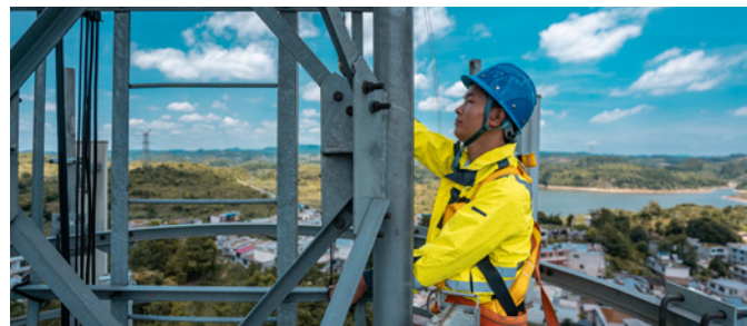
◎ 贵州移动建设乡村基站
