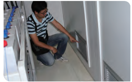
在安徽，應用基站分區制冷系統
