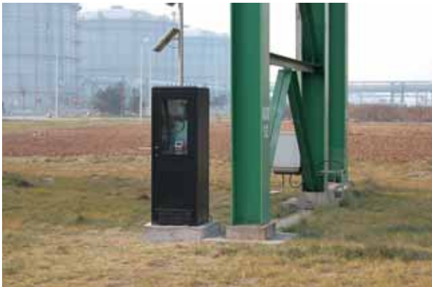
◎ 在河北，為鋼鐵公司廠區安裝污水計量監測設備
