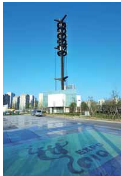
◎ 在世博園區的中國移動基站
