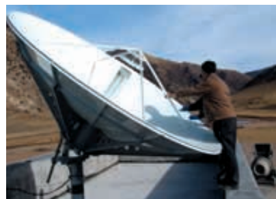
在西藏，“村村通工程”建設者調試衛星設備
